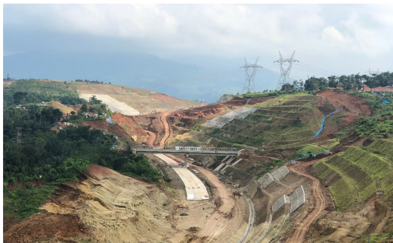
■ Jalan Tol Cileunyi-Sumedang-Dawuan, Bandung
