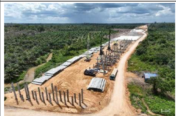
Gambar 18 Progres Konstruksi Proyek Jalan Tol Betung (Sp Sekayu) – Tempino – Jambi Seksi 4 Tempino – IC Ness
